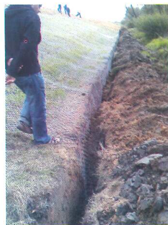
Zabezpieczenie skarpy wału przed bobrami
