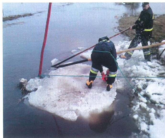
Cięcie i spławianie kry i śryżu Słupianka
