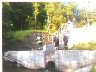
Uszkodzona i odbudowana przegroda dolinowa rzeka Słupianka
