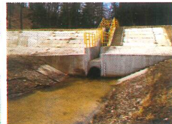
Uszkodzona i odbudowana przegroda dolinowa rzeka Słupianka
