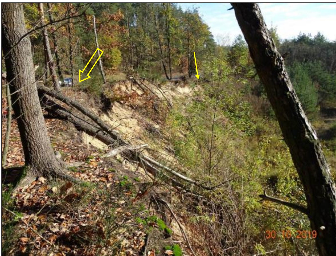
Ryc. 3 Północna kraweź głębokiego, niezrekultywowanego wyrobiska pozostawionego po eksploatacji piasków, oddalona o kilkanaście metrów od pasa drogowego DK-62. Podwójna strzałka wskazuje jadący drogą samochód, pojedyncza strzałka wskazuje widoczną na zdjęciu jezdnię drogi DK-62 w km od 148+230 do km 148+550.
