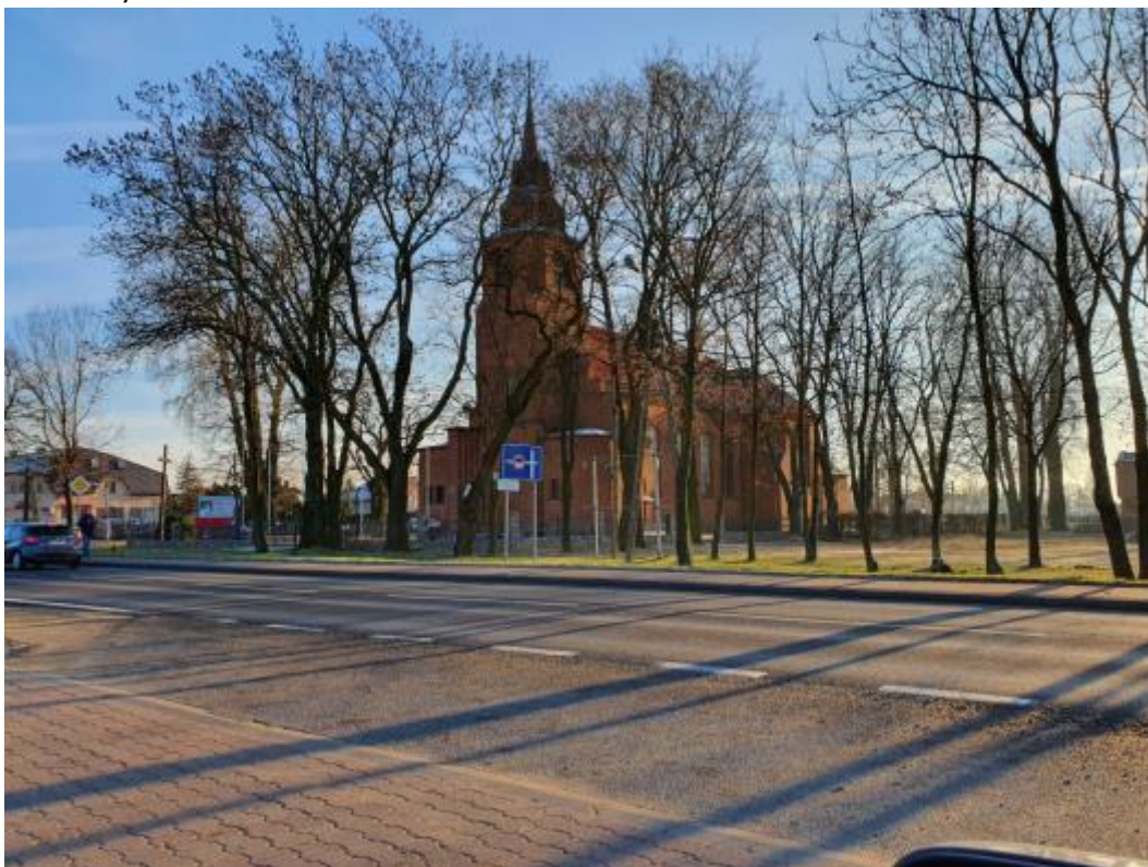
Ryc. 12 Kościół p.w. Najświętszego Serca Jezusowego w Płocku - Imielnicy, gm. Miasto Płock (567, data wpisania: 23.02.1988) km ok. 121+500.
